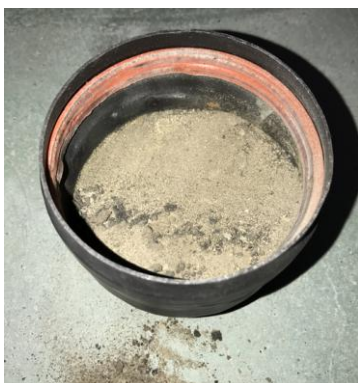
vóór het schoonmaken
